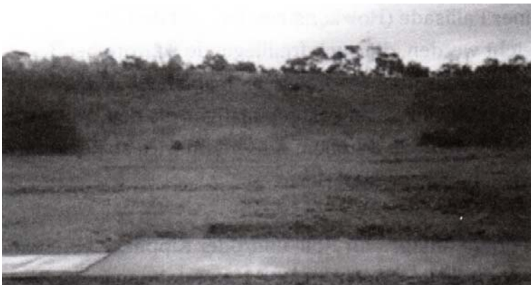
Abb. 5: Bereits begrünte Trap-Anlage mit Schrotfangwall (errichtet vor ca. 12 Jahren)
