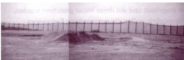
Abb. 1: Kombiniertes Schrotfangsystem aus Fangnetzen und Oberflächenbefestigung
